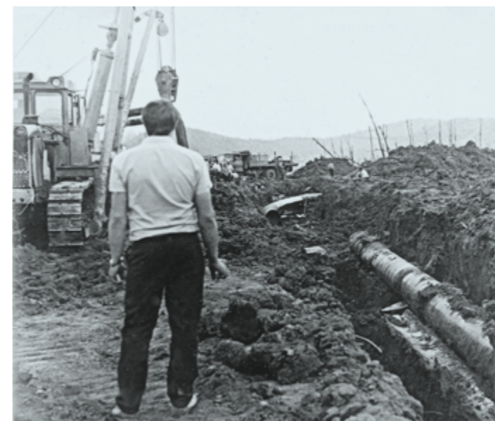
ИЗ ЭТОЙ ТРУБЫ ПРОИСХОДИЛА УТЕЧКА ГАЗА
