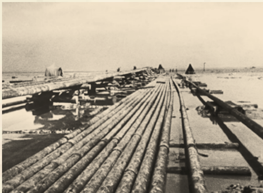
Один из участков Ладожского трубопровода
