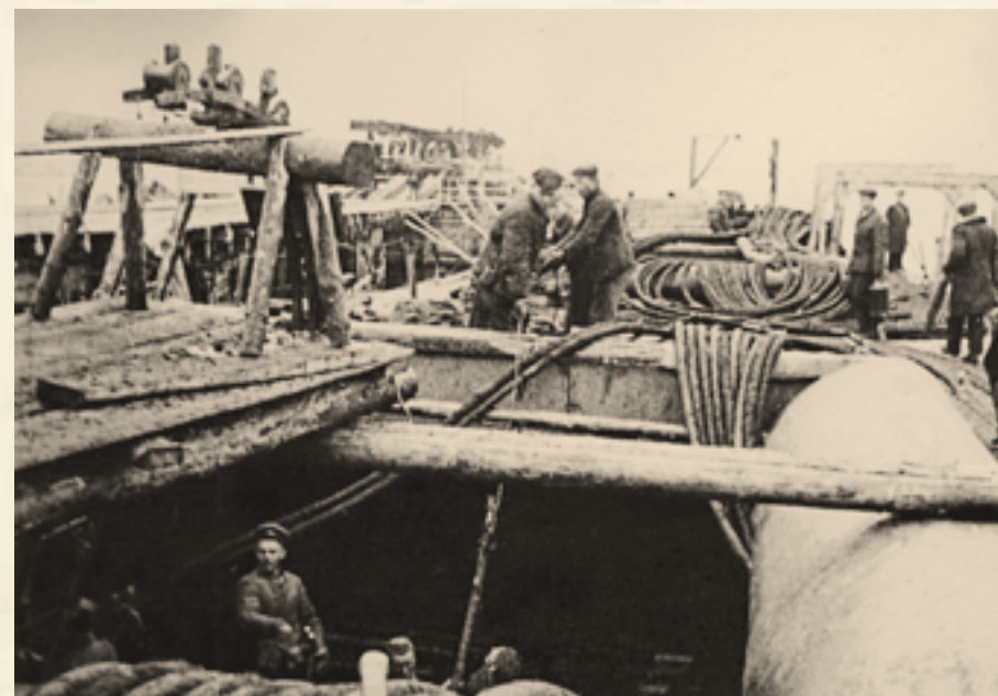
ПРОКЛАДКА ПОДВОДНОГО КАБЕЛЯ
