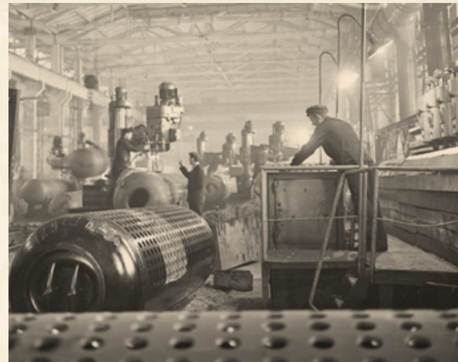
В ЦЕХУ БИЙСКОГО КОТЕЛЬНОГО ЗАВОДА. 1967 ГОД
